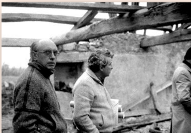
Réunion de chantier au Daviaud, à gauche Jean Thiéry, au centre, Jean-Pierre Bertrand, en janvier 1981.
